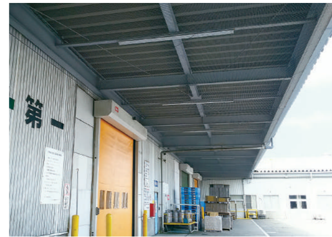
トラックヤード ひさし部
