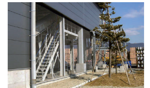
食品工場 倉庫入口
