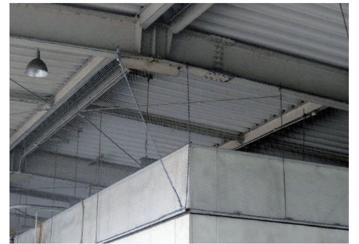
倉庫内事務所 天井部
