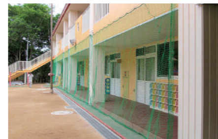
福祉施設 (ベランダ・屋外廊下)
