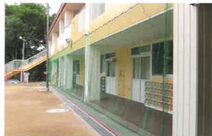
福祉施設 (ベランダ・屋外廊下)
