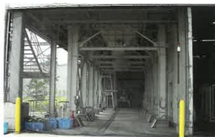
製造工場 開口部
