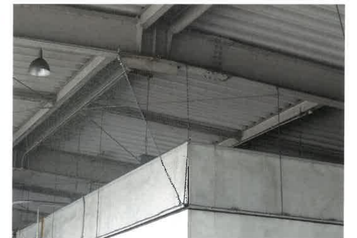
倉庫内事務所 天井部
